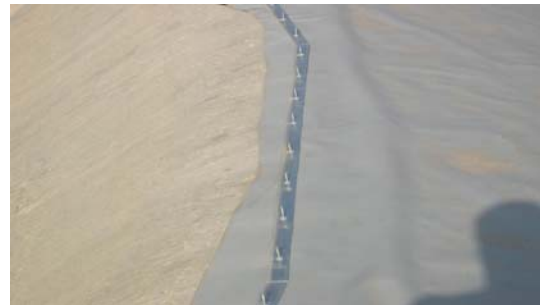
FOTOGRAFÍA Nº 6. Detalle de unión de geomembrana
