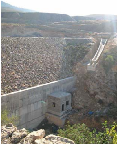
FOTOGRAFÍA Nº 9. Paramento del dique y canal de descarga
