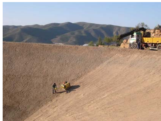
FOTOGRAFÍA N° 4. Compactación de espaldón granular
