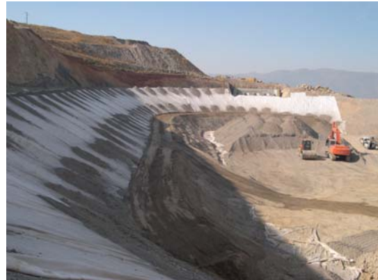
FOTOGRAFÍA N° 3. Geotextil sobre zona tratada en desmontes
