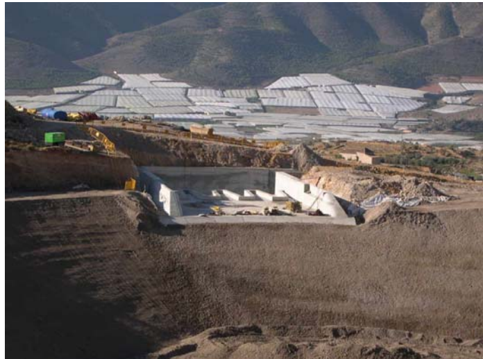
FOTOGRAFÍA Nº 10. Vertedero “en laberinto” en construcción
