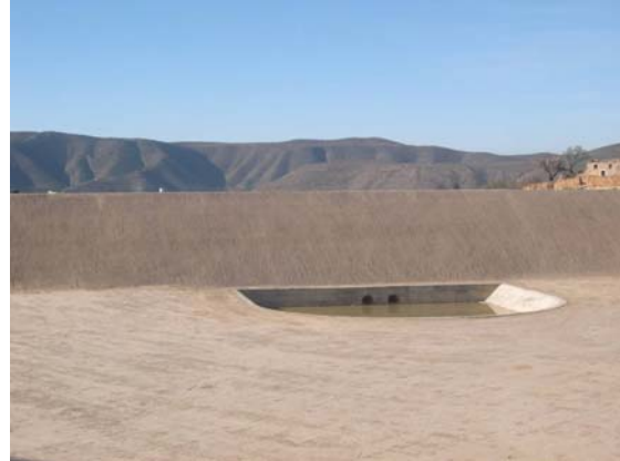
FOTOGRAFÍA N° 8. Espaldón granular tratado y arqueta de toma
