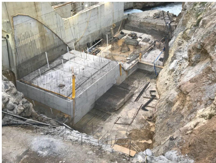
Figura 11: Presa de Renace IV en construcción
