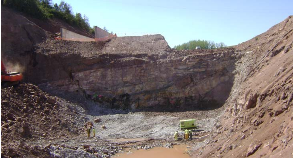
Foto n° 4: Zona del cauce, tomada desde aguas abajo
