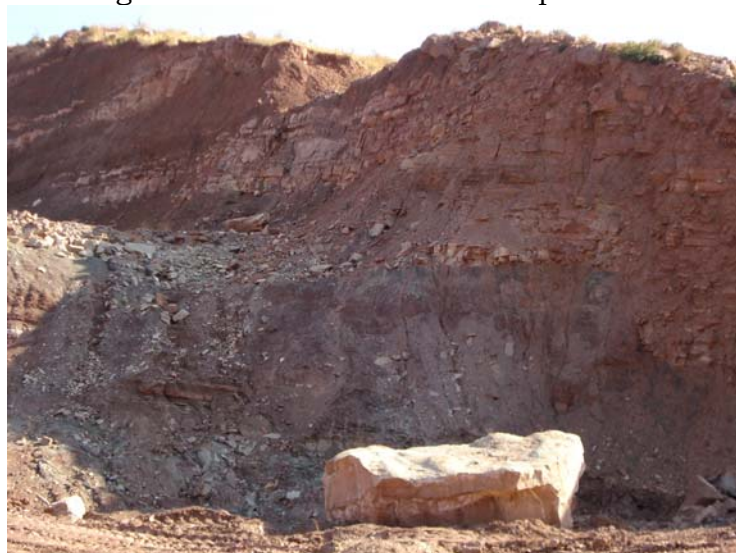
Foto nº 2: Excavación de la margen izquierda en 2007
