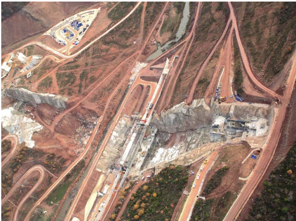
Foto n° 5: Estado de las excavaciones en 2010
