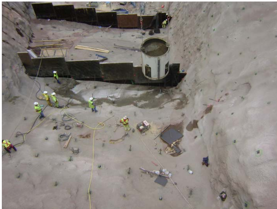
Foto n° 3: Inicio del hormigonado de un bloque superior de la ladera izquierda
