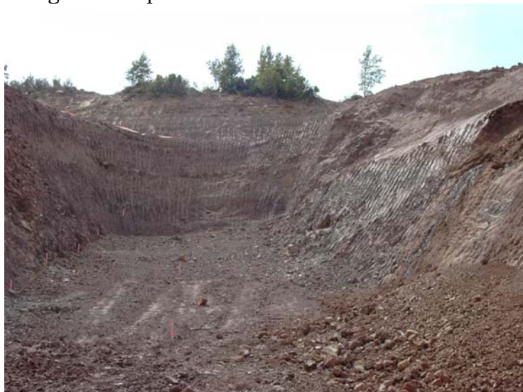
Foto nº 1: Excavación de la margen izquierda en 2004
