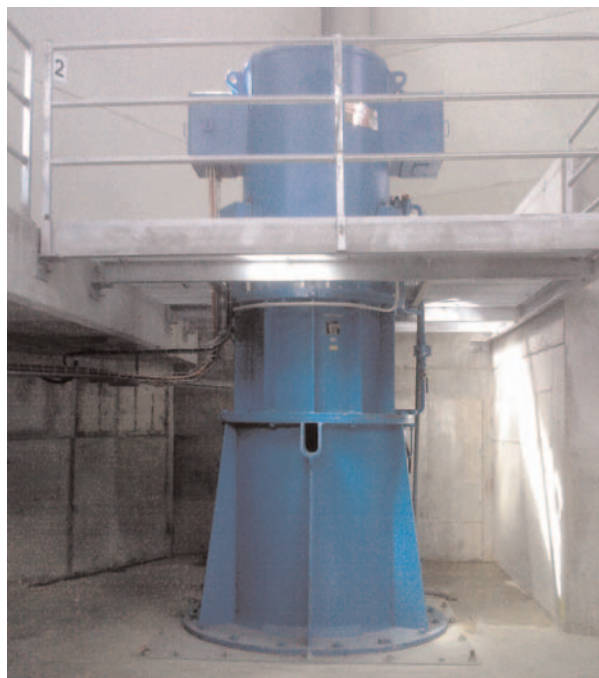
Fig. 4. Bomba TR800/9/815/ Pump TR800 / 9 / 815.
