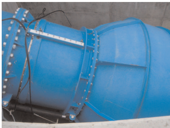
Fig. 3. Válvula Howell-Bunger/Howell-Bunger valve.
