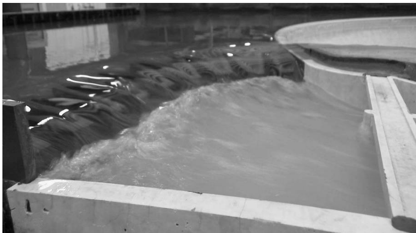
Fig. N° 4.- Aliviadero en laberinto de 9 módulos Q = 3.073 \text{ m}^3/\text{s}
