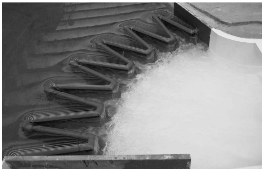
Fig N° 5. Aliviadero en laberinto de 7 módulos Q = 1.000 \text{ m}^3/\text{s}
