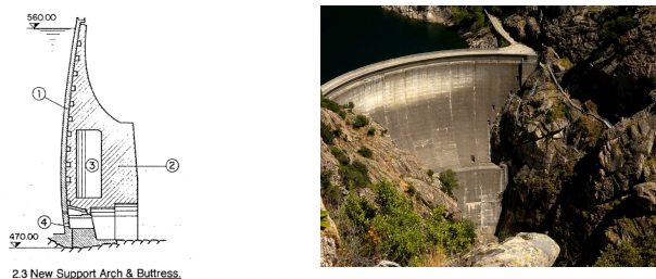
Figura 14: Refuerzo presa Tolla (Ref. 12). Y fotografía una vez rehabilitada
