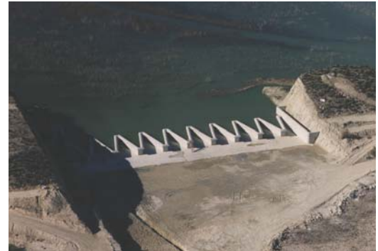
Figura N° 1. Aliviadero tipo laberinto en el embalse de Puentes (Murcia)
